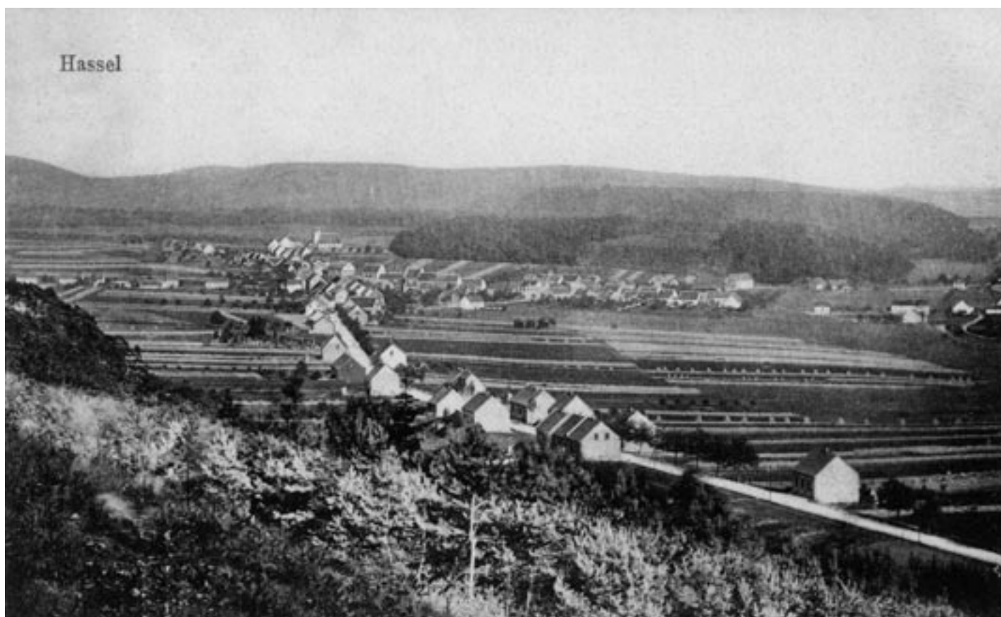
Die älteste bekannte Fotografie von Hassel um 1908. Im Hintergrund ist die 1908 erbaute evangelische Kirche zu sehen. Die Bebauung an der St. Ingberter Straße ist noch sehr lückenhaft, aber noch stehen die Chausseegebäude.
