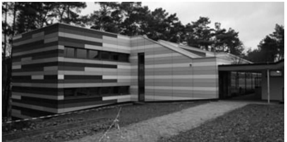
... die Eisenbergschule nach der Sanierung 2010.
