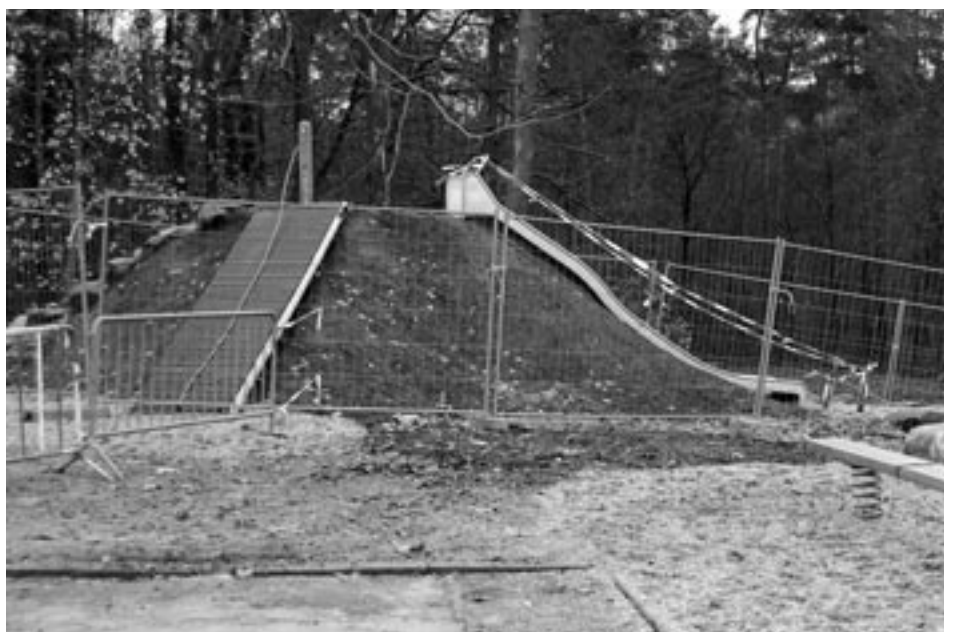
Der neugestaltete Außenbereich mit neuen Spielgeräten kurz vor der Fertigstellung.
